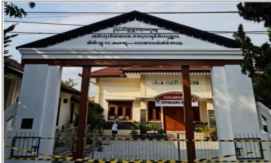
Gambar 4.30. Rehabilitasi Gapura Panti Wredha Bangunan Cagar Budaya Kota Surakarta
