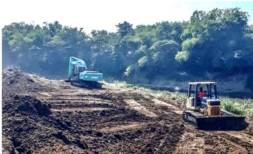
Gambar 2.34 Pembangunan Pintu Air Kali Pepe
