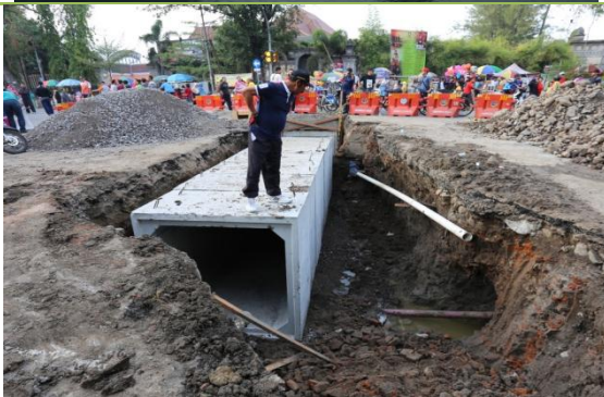
Gambar 4.23 Proses pemasangan Box culvert di Kota Surakarta
